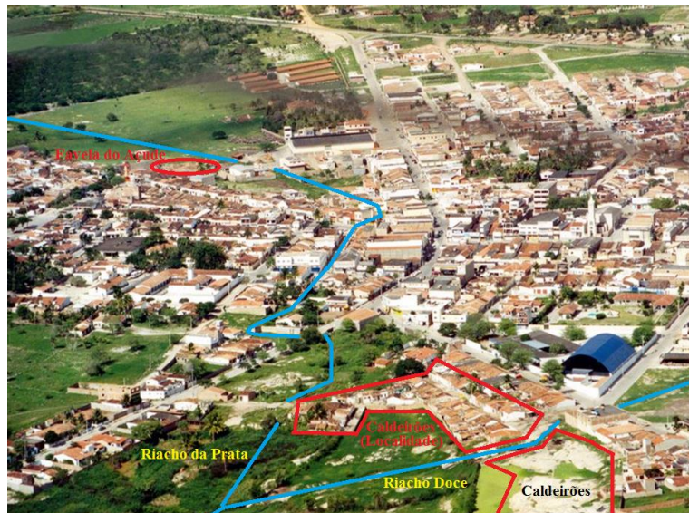
Foto 2: Localização dos Caldeirões na cidade de Lajedo
