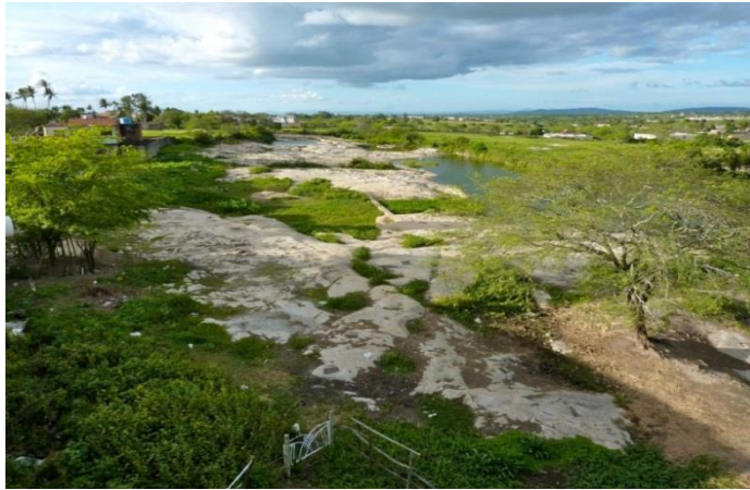
Foto 1: Acumulação D'água na Estrutura rochosa dos Caldeirões
