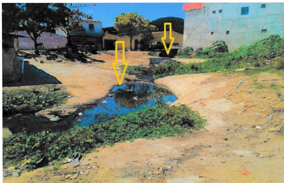
Figura 08: Um das entradas que dá acesso aos Caldeirões totalmente aberta
